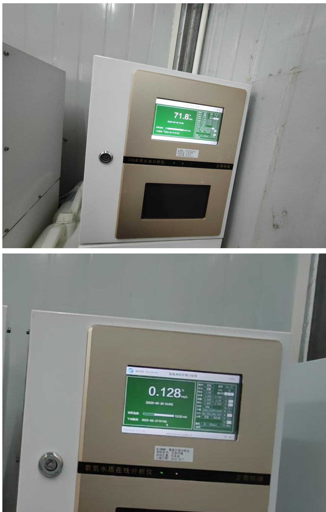
图 2.2-1 现有项目废水处理站出水 pH、COD、氨氮在线监测（已联网）
